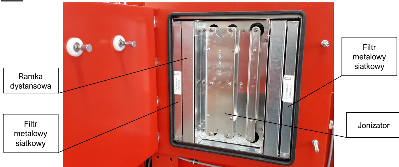
Fotografia 2 Wnętrze komory filtracyjnej
