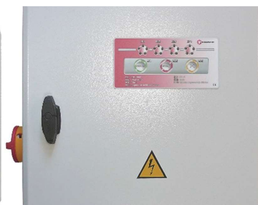
Rysunek 30 Wygląd elewacji rozdzielnic elektrycznej
