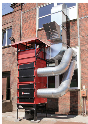
Stocznia Remontowa, Gdańsk spawanie
