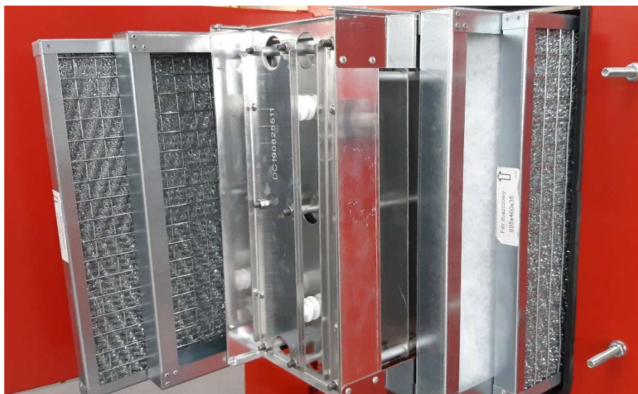
Fotografia 3 Kolejność ułożenia elementów filtracyjnych
