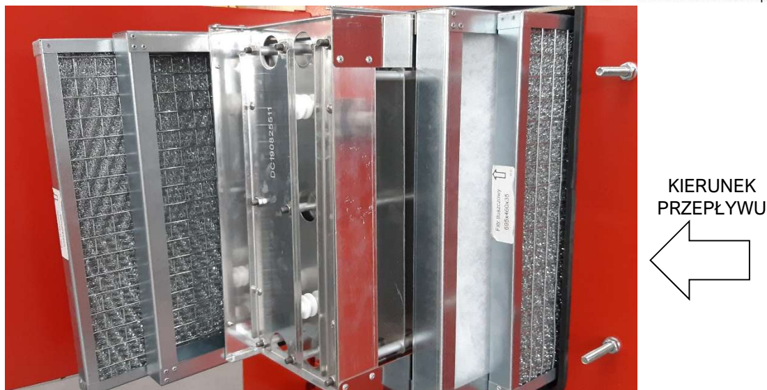
Fotografia 3 Kolejność ułożenia elementów filtracyjnych
