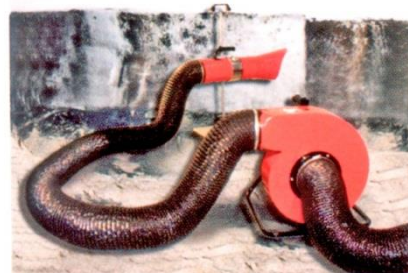
Wentylator przenośny osuszający zawilgoconą ścianę
