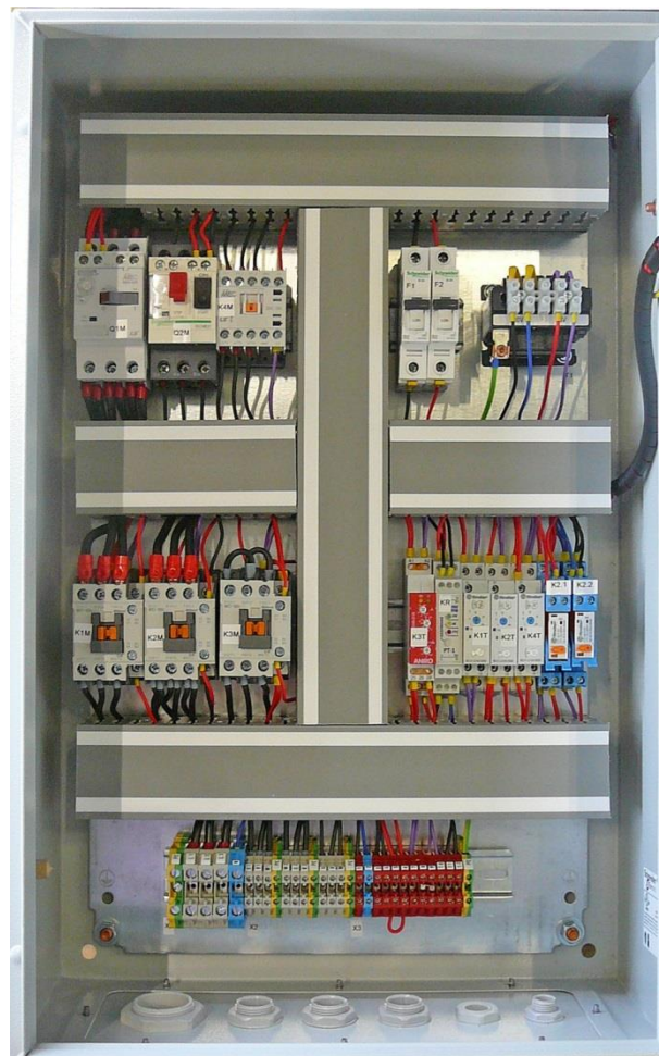
Rys. 10 Rozdzielnica - wewnątrz
