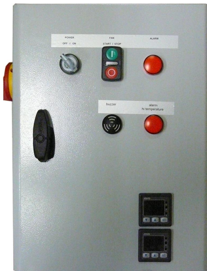
Rys. 10 Rozdzielnica A1, elewacja
