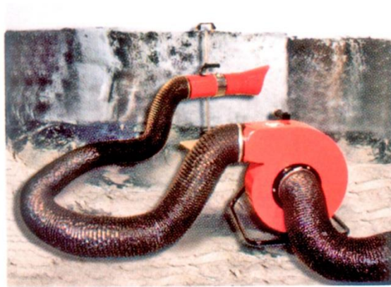
Wentylator przenośny osuszający zawilgoconą ścianę
