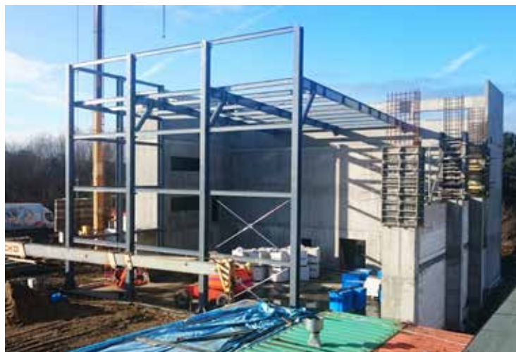
Studio Panika w budowie
