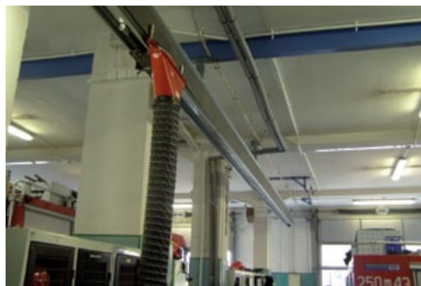
System odsysaczy spalin w Szkole Głównej Służby Pożarnej w Warszawie
