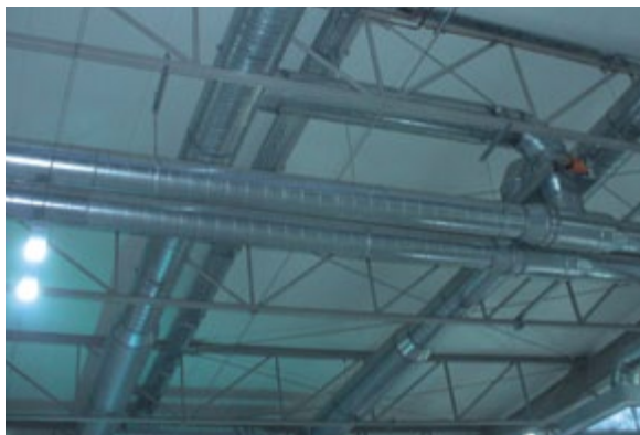
Instalacja wentylacji ogólnej wykonana przez Klimawent S.A.
