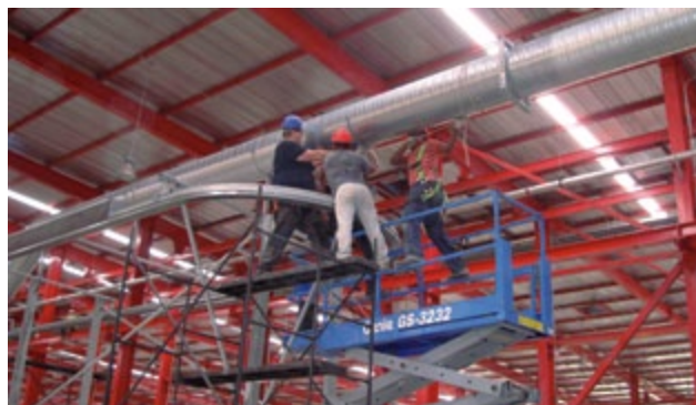
Półmetek budowy. Na rusztowaniu Roman Fudalewski wraz z wenezuelskimi pomocnikami Pablem i Diego.
