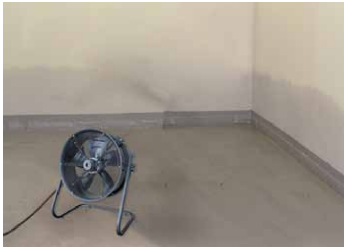
Beispiel für die Anwendung des Gebläses zum Trocknen von Räumen
