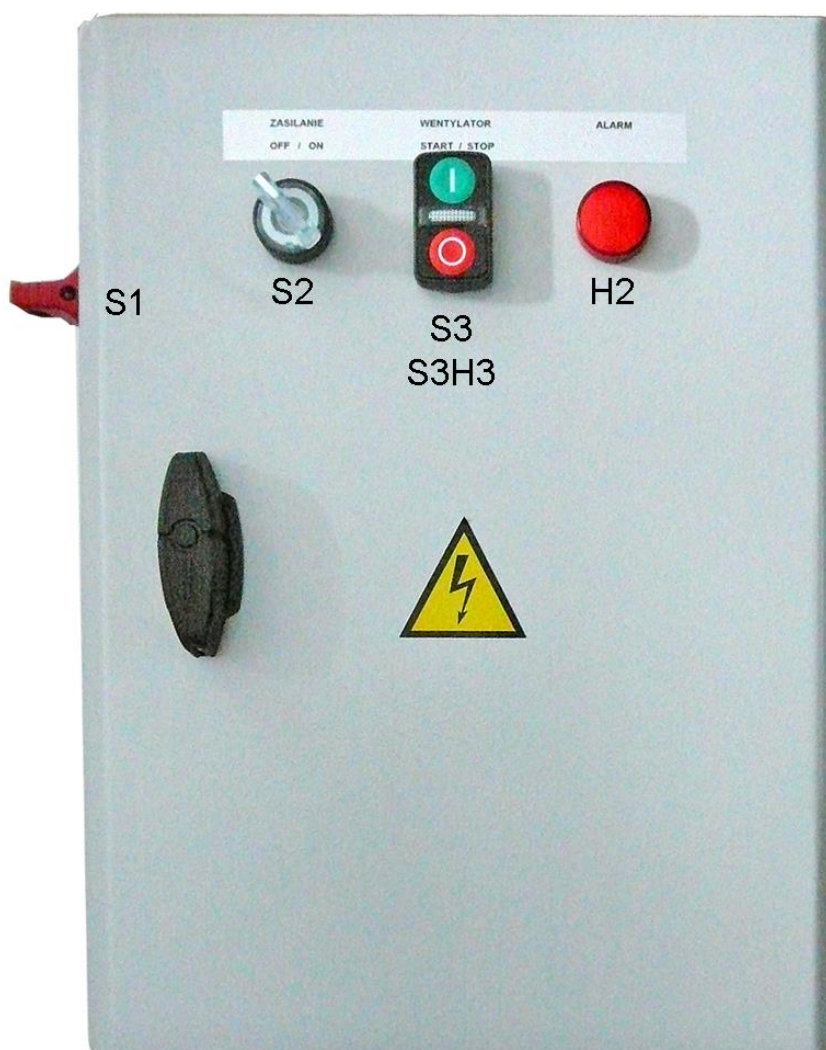
Rys. 9. Rozdzielnica A1
