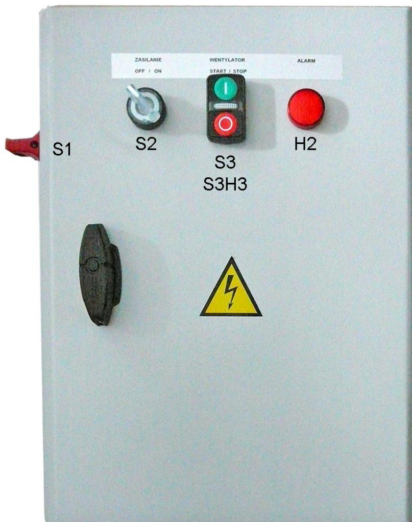
Rys. 9. Rozdzielnica A1
