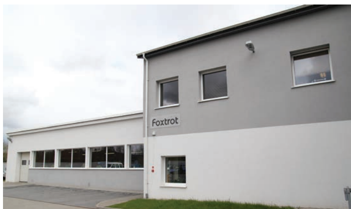
Zmodernizowany budynek produkcyjny
