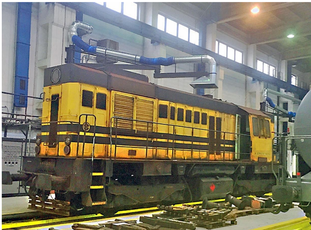
Fot. 1 Zastosowanie zestawu wyciągowego typu ROL-GOL
